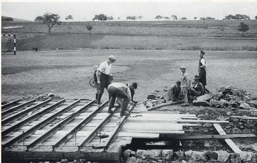
1932: Beim Bau der „Sportplatzbrücke“.
