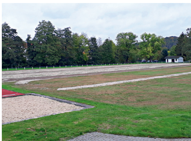
Mit dem Verteilen des Sandes begannen die Arbeiten.
