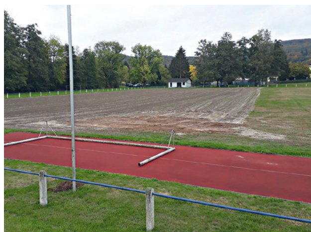
Danach wurde die Rasentragschicht verteilt.
