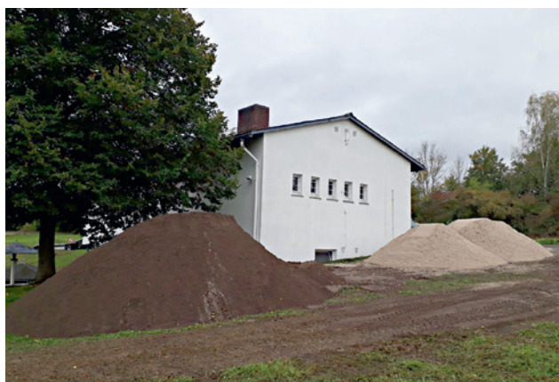
Das zur Erneuerung des Rasenplatzes angelieferte Material wartet auf seinen Einsatz.
