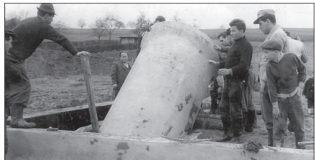
Bei der Verlegung des Gartens waren auch eine Mauer (im Vordergrund) und ein Brunnen anzufertigen. Dafür wird hier ein schweres Betonrohr in eine Grube eingelassen. (Von links:) Ernst Pfaff (im Hintergrund), Walter Weber, Bernd Heiselbetz, Gerhard Scharf
