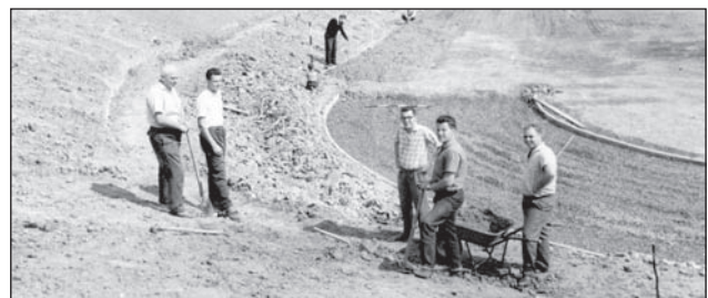
... aber es war auch viel Handarbeit mit Hacke, Schaufel, Spaten und Schubkarren erforderlich. (Von links:) Rudolf Anschütz, Jürgen Keller, Gerhard Scharf, Bernd Heiselbetz, Erhard Simon.
