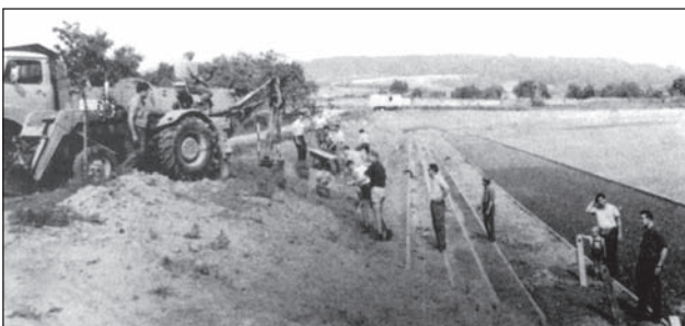
Zum Anlegen der Böschung und Stehterrassen, die viel Erdbewegung erforderlich machten, stellten Unternehmen kostenlos Bagger und LKWs zur Verfügung ...
