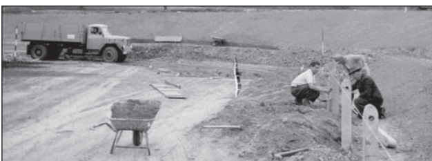
Setzen der Einzäunungsständer unter Anleitung von Bauingenieur und Vereinsmitglied Walter Weber. Diese Betonpfosten wurden alle von Friedrich Simon und Otto Schmidt von Hand angefertigt.
