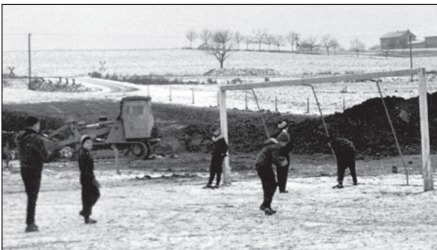
Das letzte Foto vor dem Umbau. Der Bagger ist schon im Einsatz. Um die Umbaumaßnahmen zu beschleunigen, verlegte der Verein in Eigenleistung den privaten Garten mit dem Gartenhäuschen in unmittelbare Nähe.
