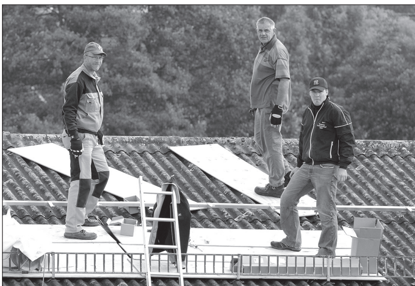
Auf's Dach gestiegen: Martin Zeipelt, Klaus Schäufler und Nils Knapp. (von links)
